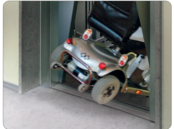
Scooter Unfall mit einer ungesicherten Aufzugtür Mobility scooter accident with an unsecured lift door
