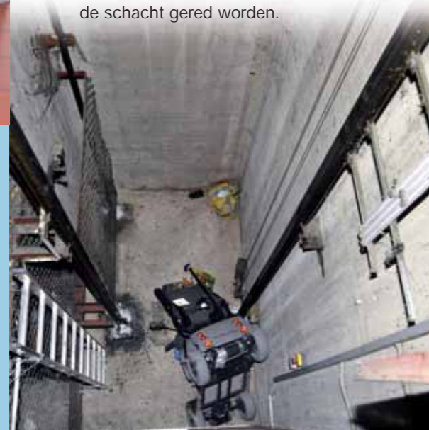
Ongeval met scootmobiel in een seniorenwoning in mei 2010. De uit de onderste geleiding gesprongen deurpanelen zijn duidelijk zichtbaar. (Foto's: B.Z./Timo Beurich)
