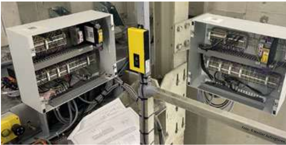
Verdrahtung MIT Easy Installation Kit + Service Box. / Wiring with Easy Installation Kit + Service Box.
